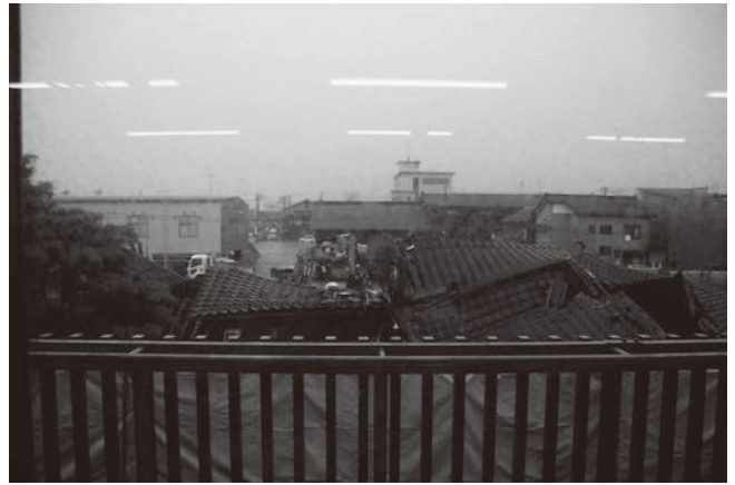
崩れてぐねぐねと波打っているかのような瓦屋根と、解体するショベルカー。
