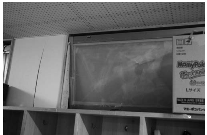
右隣の窓はまったく閉まらなくなってしまったため、外からベニヤ板などで閉じている。壁にも大きな亀裂が見える。
