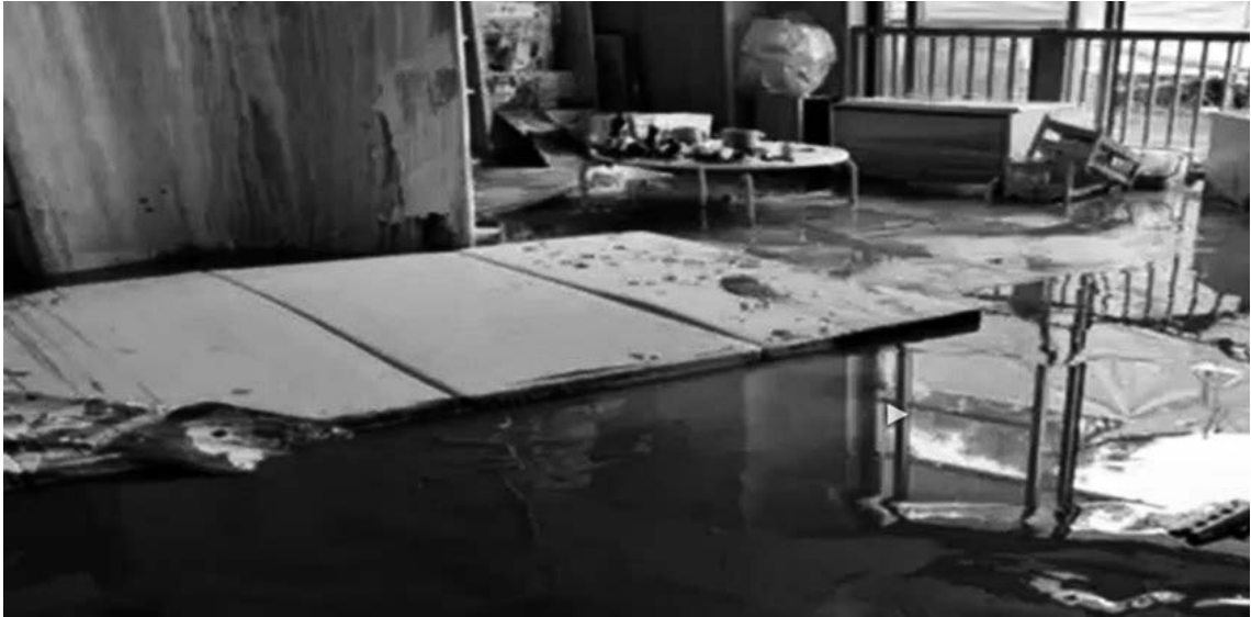
9月21日の水害で泥水が80センチも入り込んでしまった1階の部屋。
